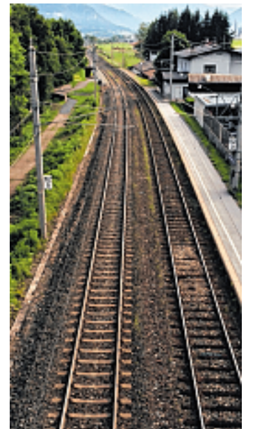
An den Gleisen in Oberndorf erfolgen bald Baumaßnahmen. Foto: ÖBB
